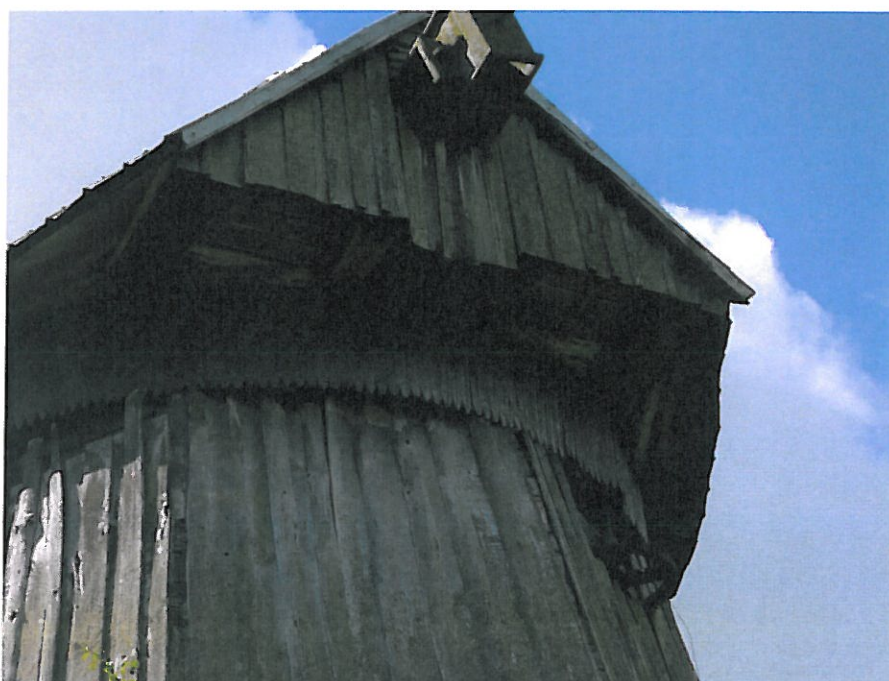
Fot. 4: Ściana szczytowa z wpustem na śmigła
