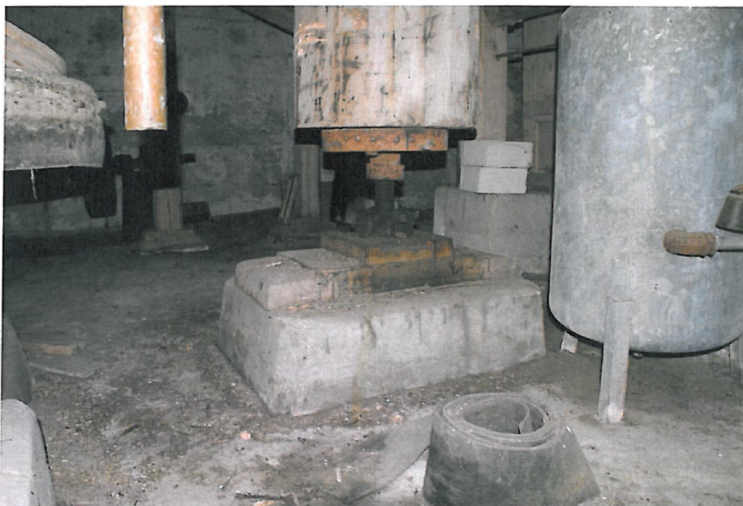
Fot. 10: Betonowa podstawa pionowego wału napędowego
