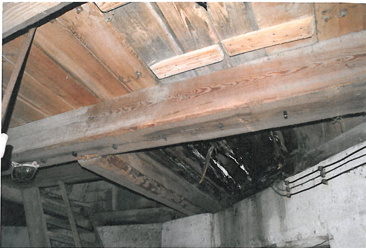
Fot. 7: Stan stropu drewnianego nad piwnicą
