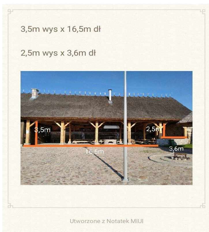
Rys. 1 Miejsce instalacji żaluzji zabezpieczającej
