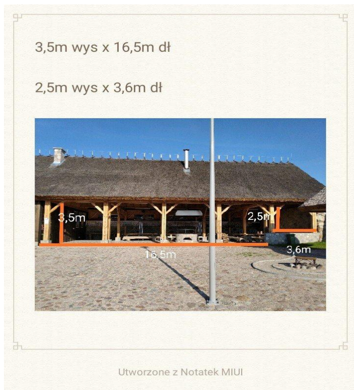
Rys. 1 Miejsce instalacji żaluzji zabezpieczającej
